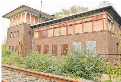
Aus den 1950er-Jahren dürfte das alte Hauptstellwerk an der Schnittstelle zwischen Köln-Mindener-Bahn und Werksbahn stammen. Es greift die nüchterne Architektursprache auf, die für Zollverein so typisch ist. FOTOS: BRITTA PRASSE
